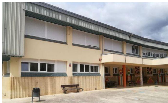
Imagen 32: Obras de envolvente térmica. Sustitución de carpintería en el colegio público de Zubiri.
