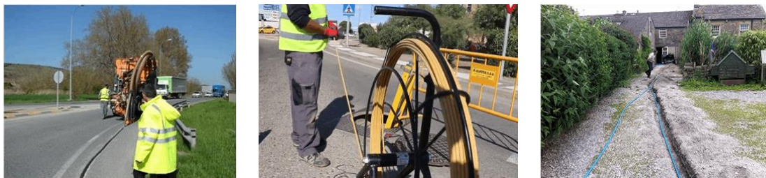
Imagen 11. Despliegues de redes de fibra óptica por carretera (red de transporte), y por ciudad o en una zona rural (redes de acceso).
