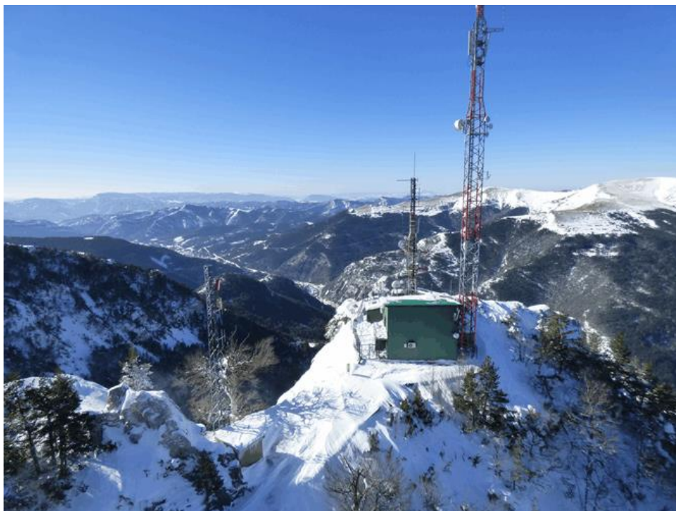
Imagen 15. Centro de Telecomunicaciones de Gobierno de Navarra en Isaba. Fuente: Nasertic.
