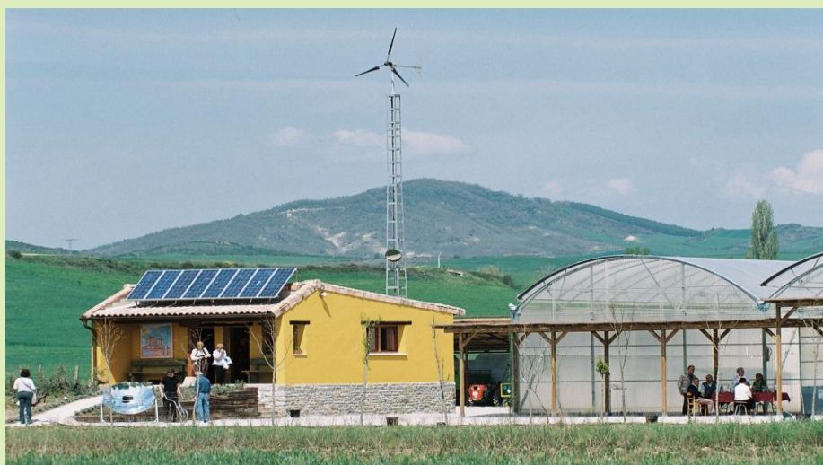
Instalación de autoconsumo en la finca Bordablanca de Josenea (Lumbier)
