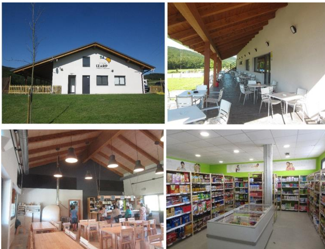
Imagen 5. Construcción del equipo dotacional del Camping Izarpe en Aroztegi (Valle de Atez). Proyecto cofinanciado por el PDR 2014-2020. Convocatoria 2016
