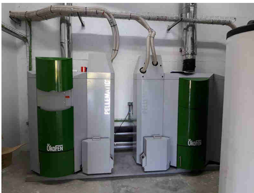
Imagen 19. Instalación de caldera de biomasa. CP Irain IP. Lesaka.
