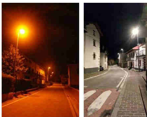
Imagen 18. Oroz Betelu. Renovación del alumbrado público exterior. A la izquierda, antes de la actuación. A la derecha, después de la actuación.
