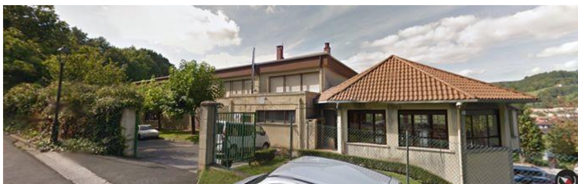
Imagen 26. Vista del CEIP Irain de Lesaka. Proyecto de reforma de sala de calderas y certificado de eficiencia energética del edificio antes y después de la reforma.
