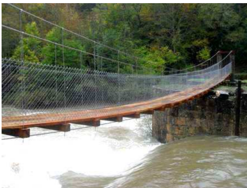
Imagen 9. Pasarela recuperada en Aribe.
